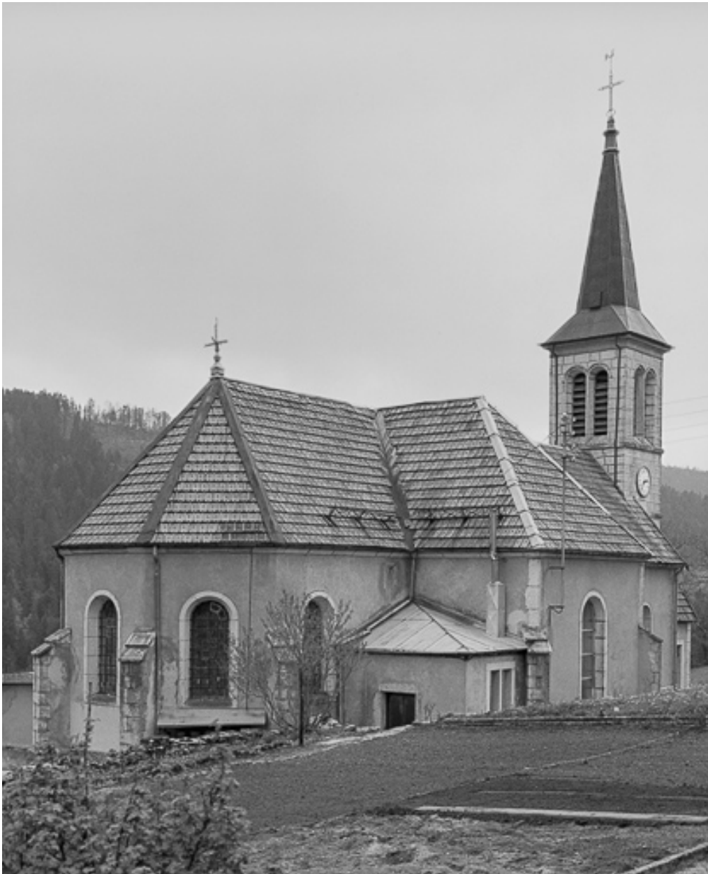
Façades postérieure et face latérale gauche.
