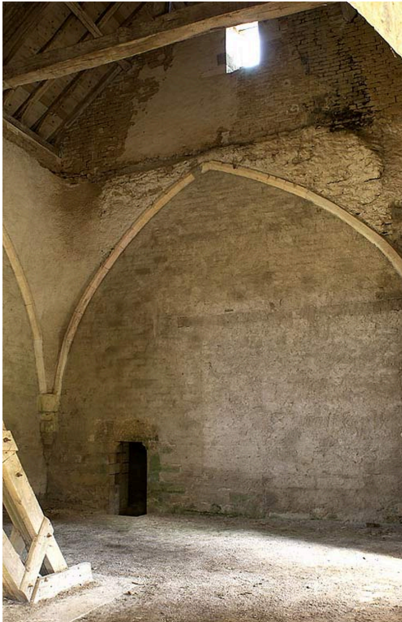
Cellier : rez-de-chaussée, salle nord (vue d'ensemble du mur nord).
