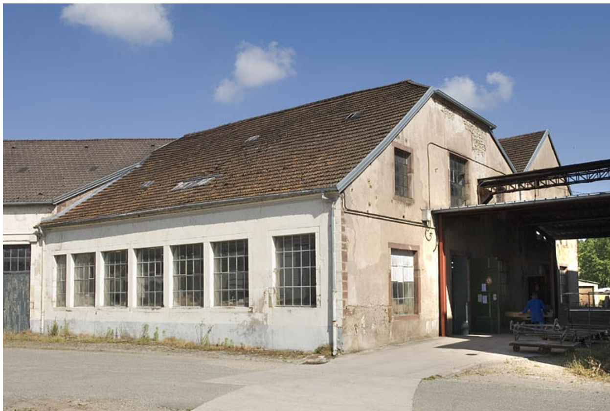
Atelier de fabrication originel. Vue de trois quarts.
