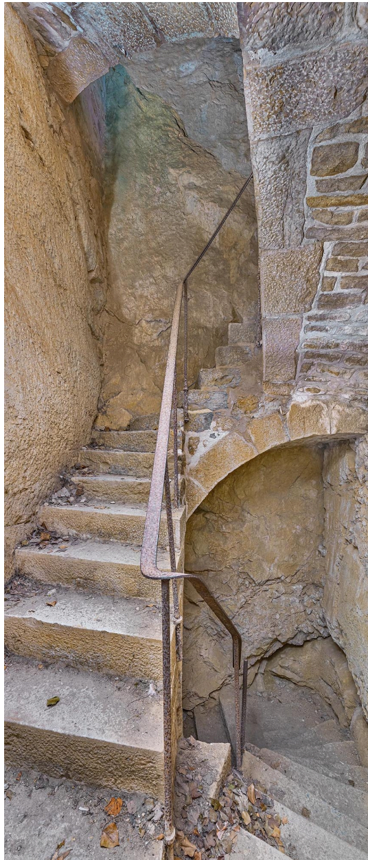
Escalier desservant les étages inférieurs.
