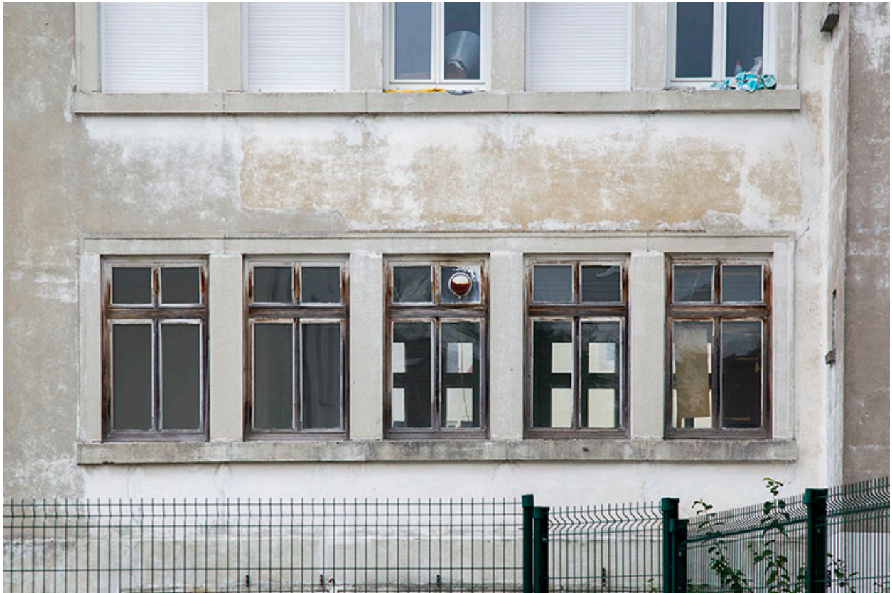
Façade postérieure : fenêtres multiples.
