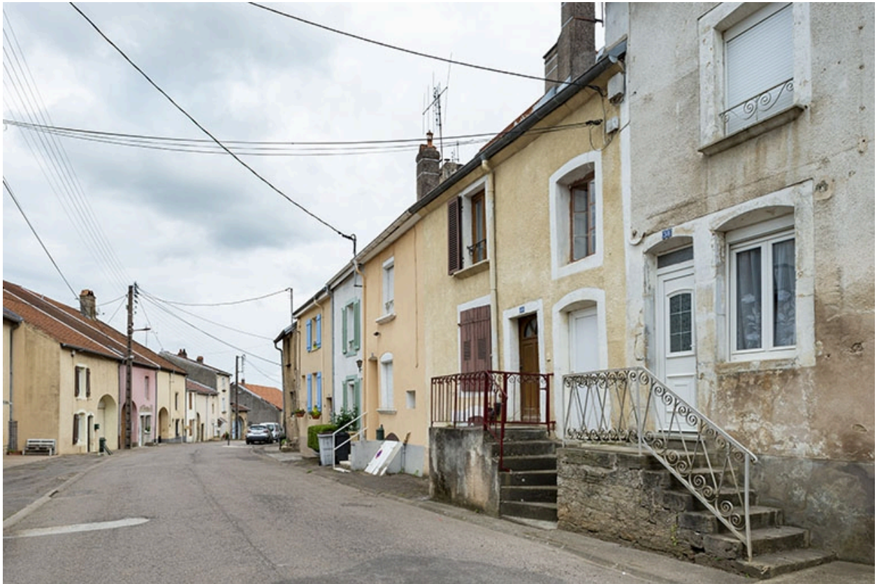
Rue Thiers, alignement du côté pair devant le n° 36, vue vers le nord-est.
