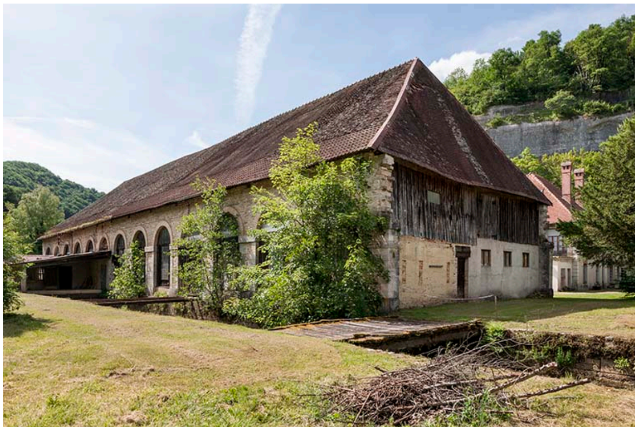
Atelier de fabrication depuis le sud-est.
