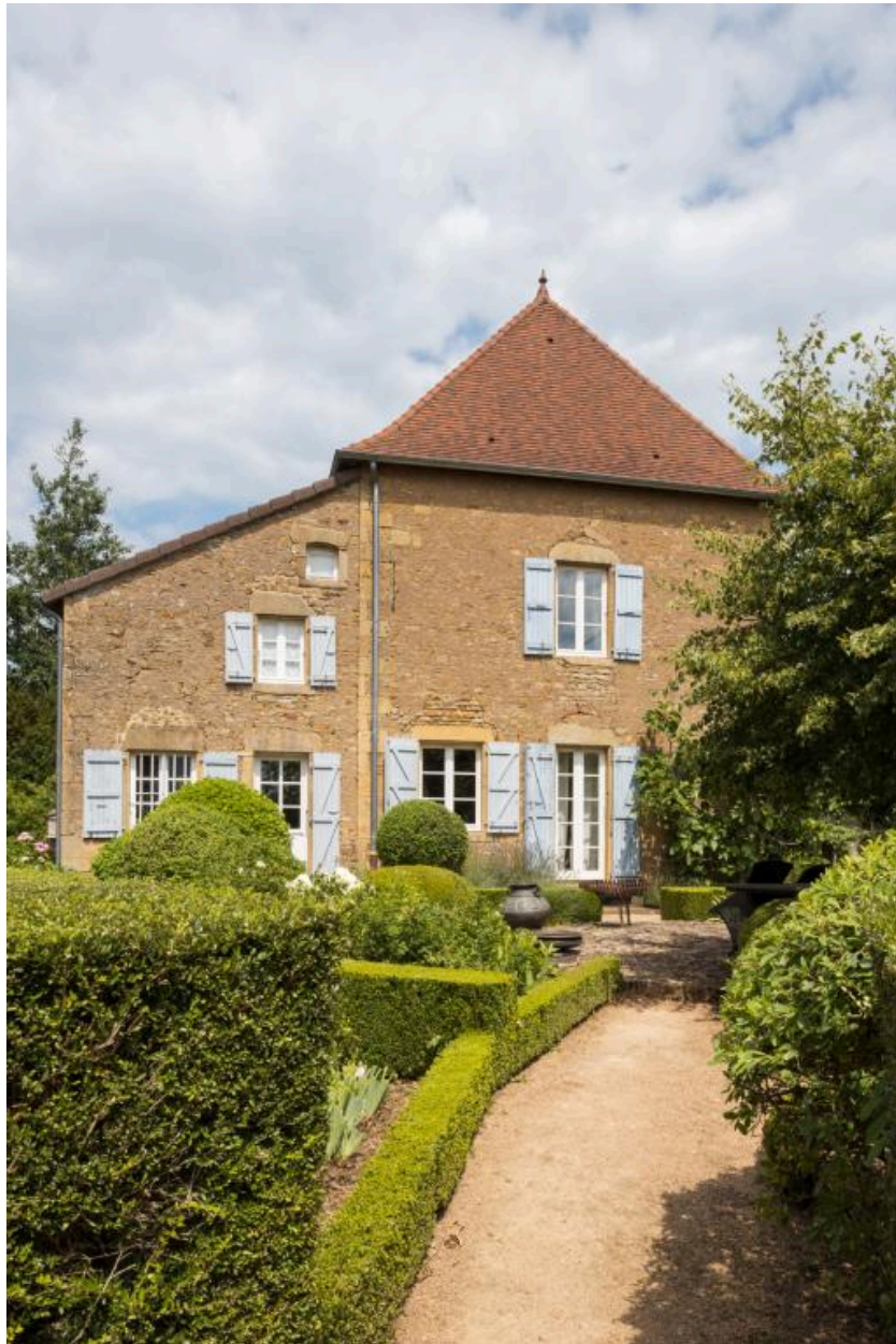
Façade latérale ouest de la maison
