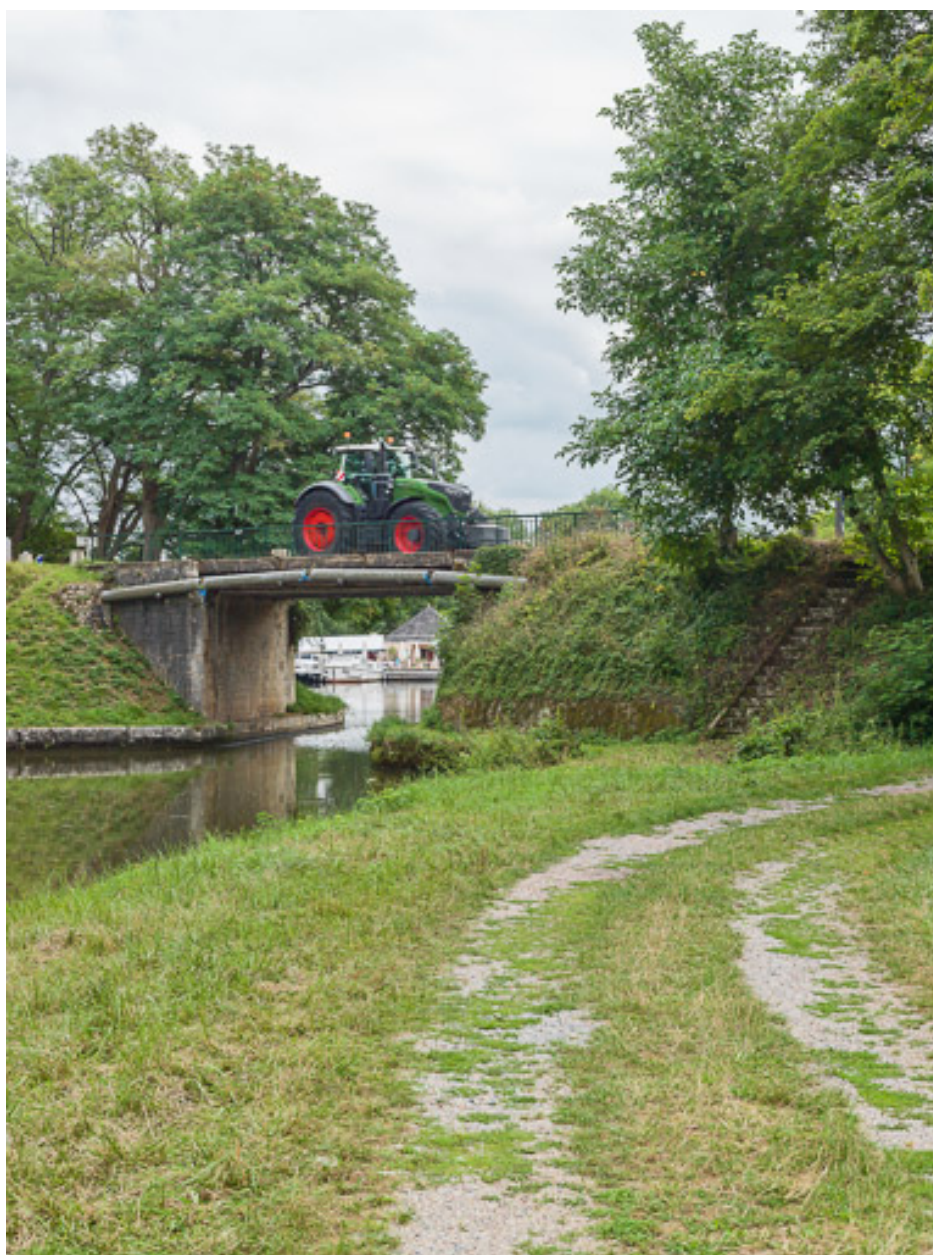
Vue d'ensemble du pont.
