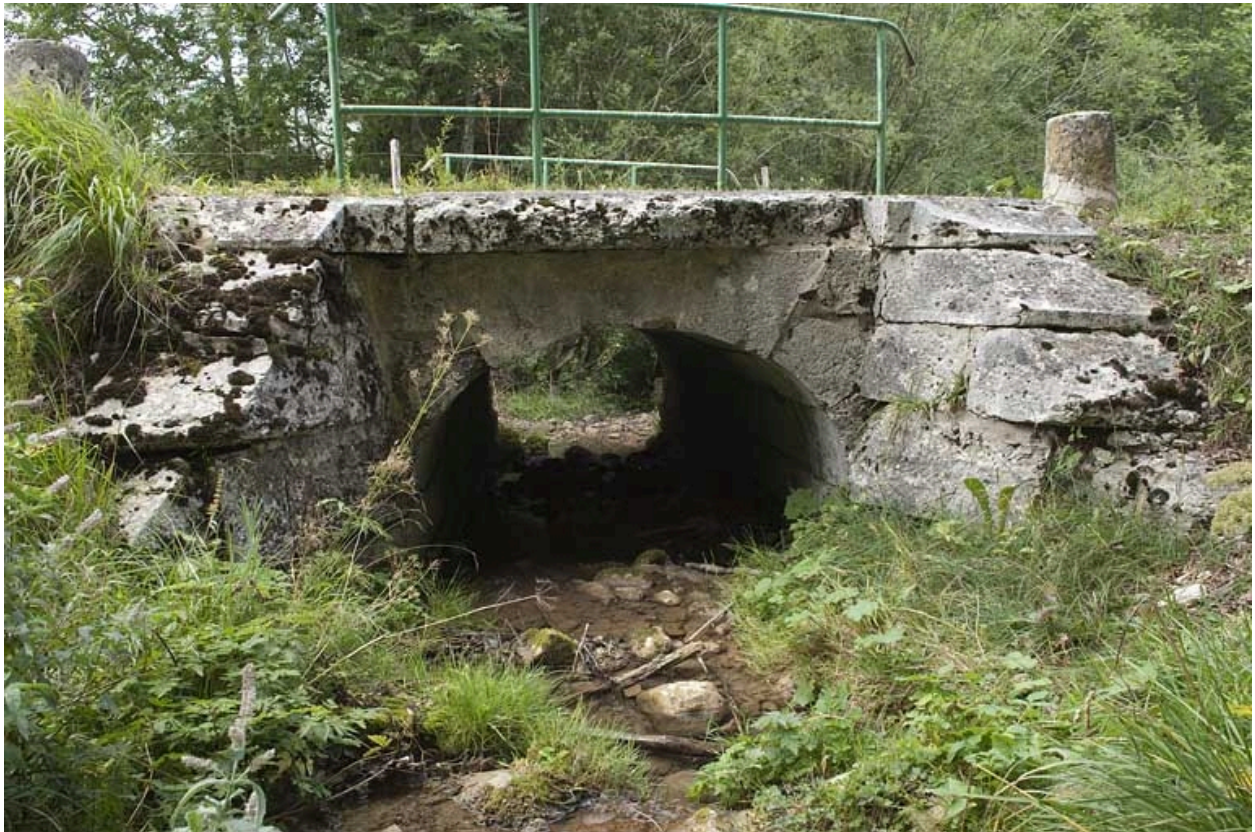
Pont du ruisseau de la Goulette (n° 18), vu depuis l'amont.
