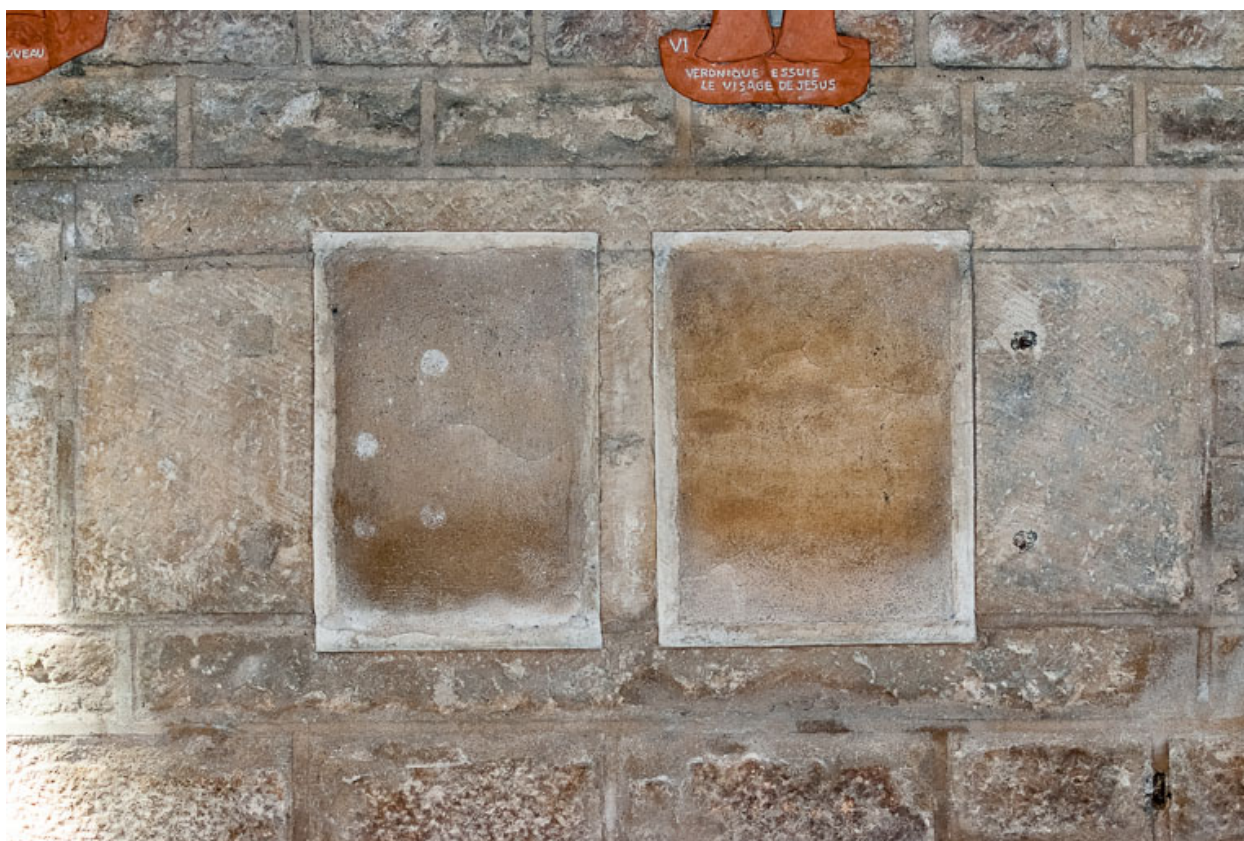
Lavabos murés, mur nord de la nef.
