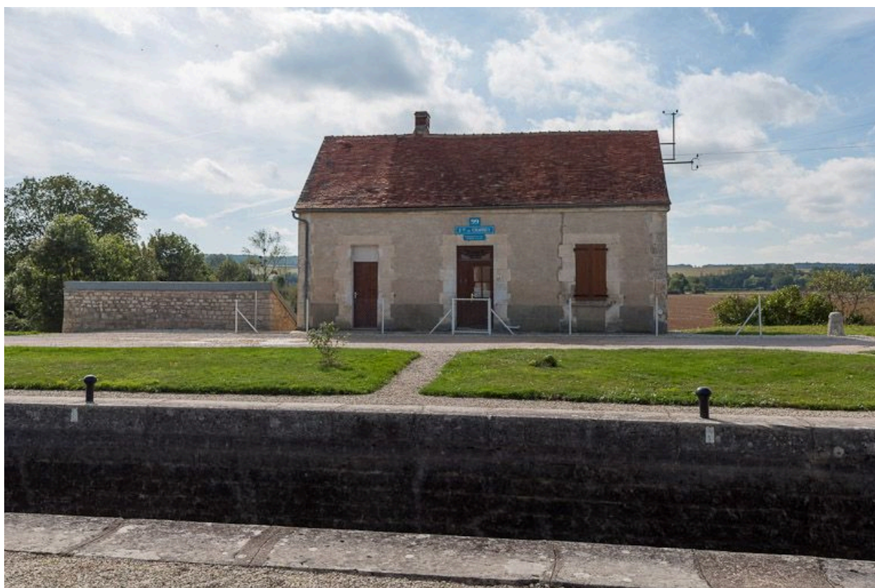
Maison éclusière vue de face.
