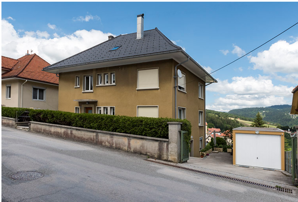
Façades antérieure et latérale droite.
