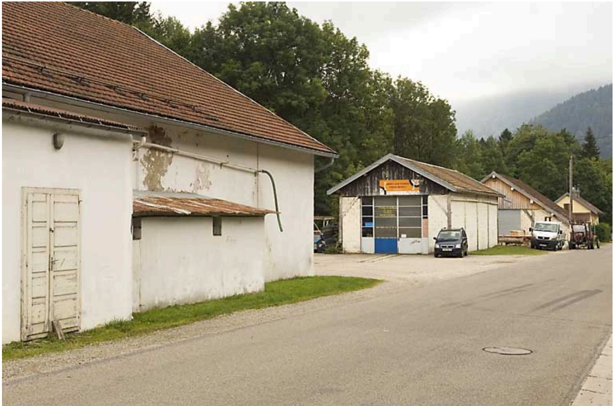
Partie sud du site : vue générale.
