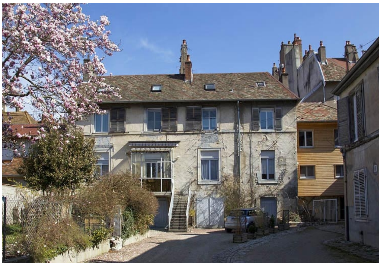
Vue du premier logis secondaire, de face.
