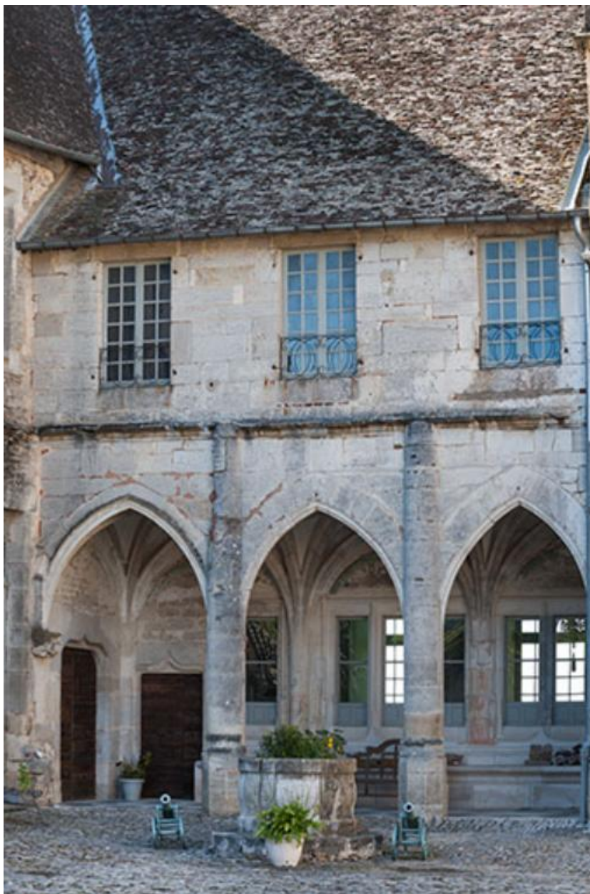
Les arcs brisés de la galerie
