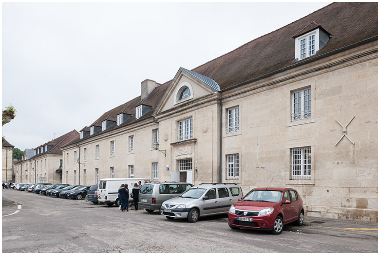
Bâtiment restauration-externat : façade postérieure.
