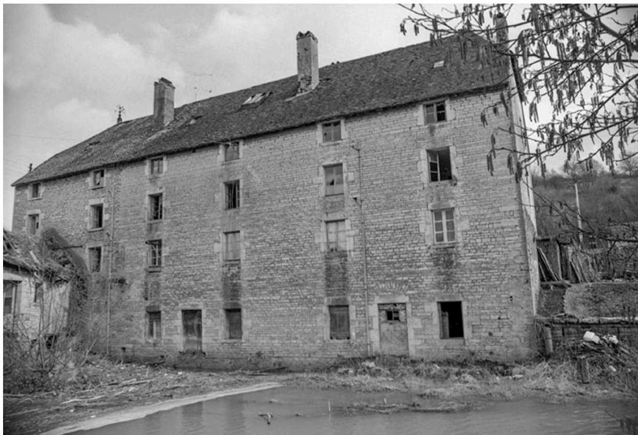
Logement ouvrier. Façade ouest en 1979.
