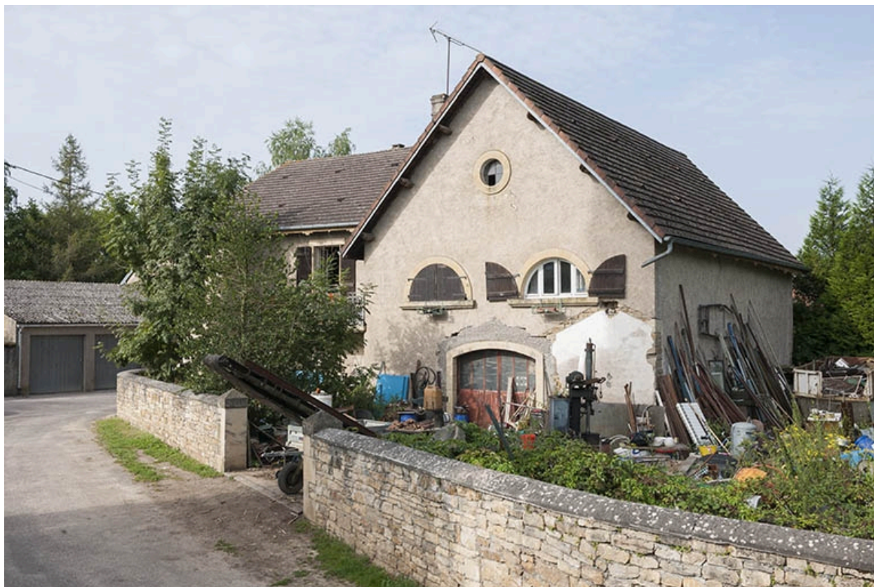
Façades latérale droite et postérieure.
