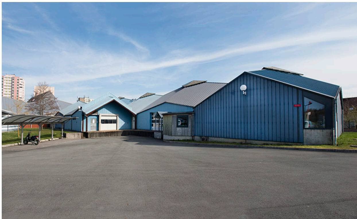
Façades postérieures ouest des ateliers de mécanique.
