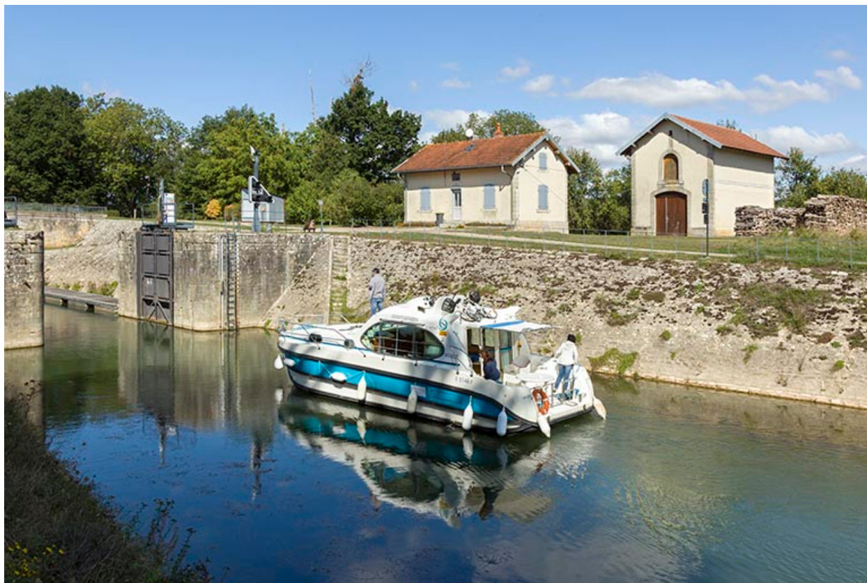
Ecluse de Ferrières-lès-Ray.
