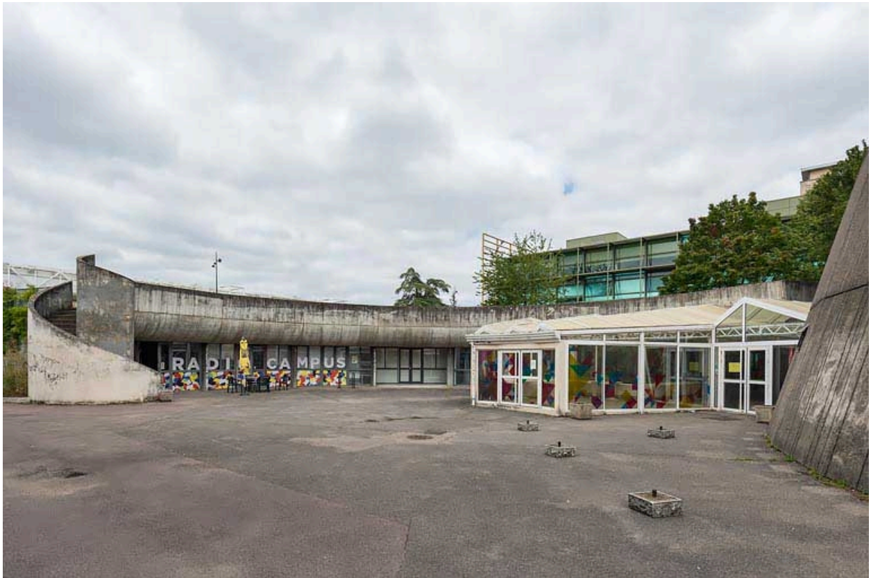
Façade sur cour.
