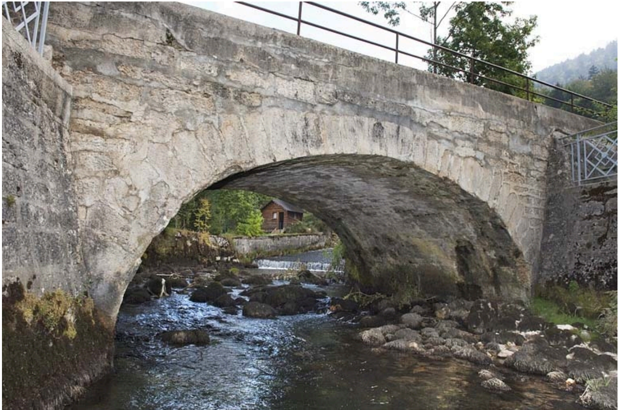
Pont sur la Jougne (n° 13), vu depuis l'aval.
