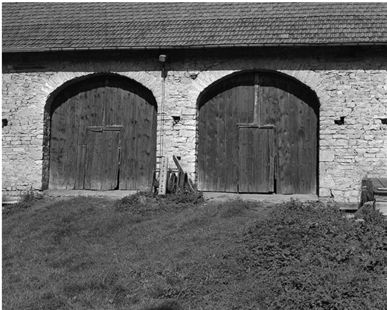
Entrées de granges geminées.
