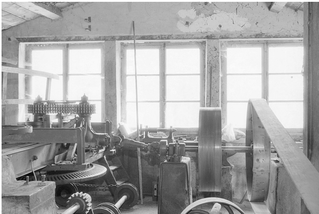
Transmission entre la turbine et la dynamo.
