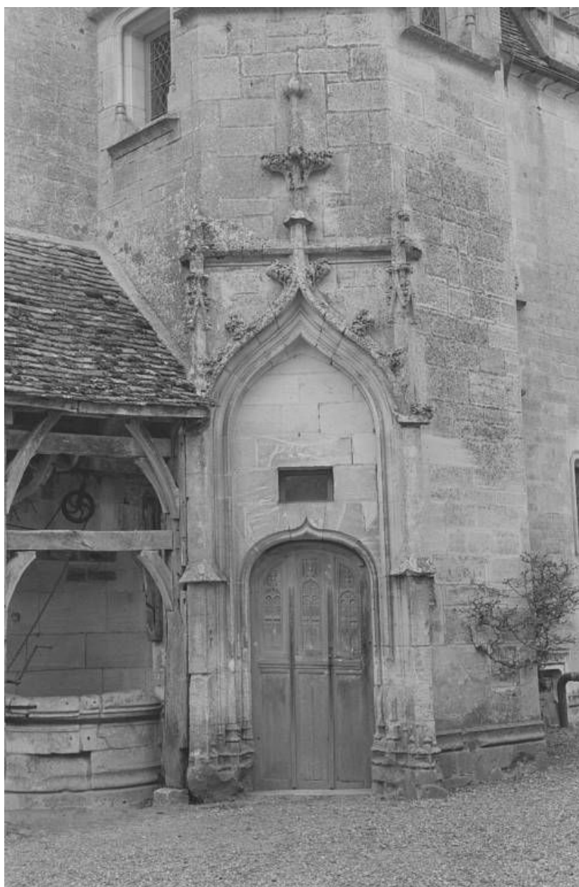
Porte de la tour d'escalier (corps de logis) (photo prise en 1969).
