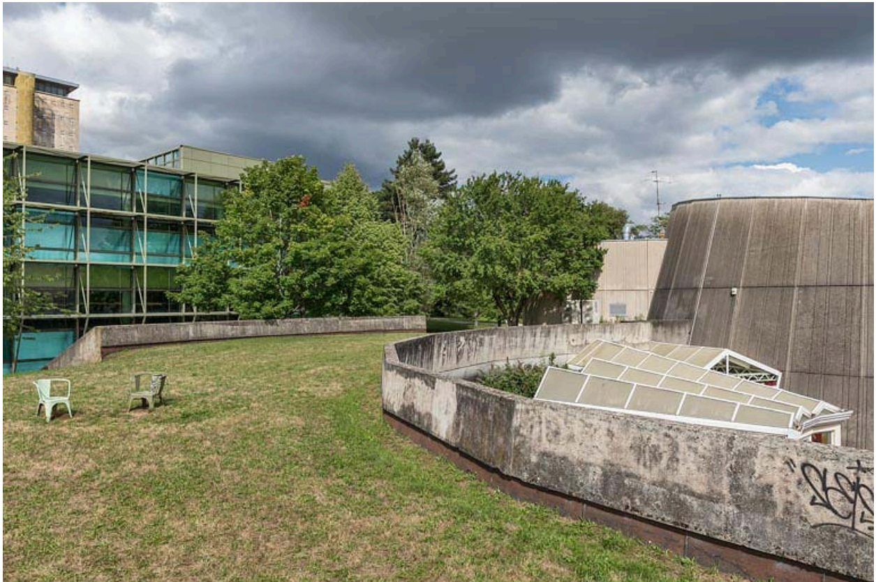
Aile semi-circulaire : toiture végétalisée.
