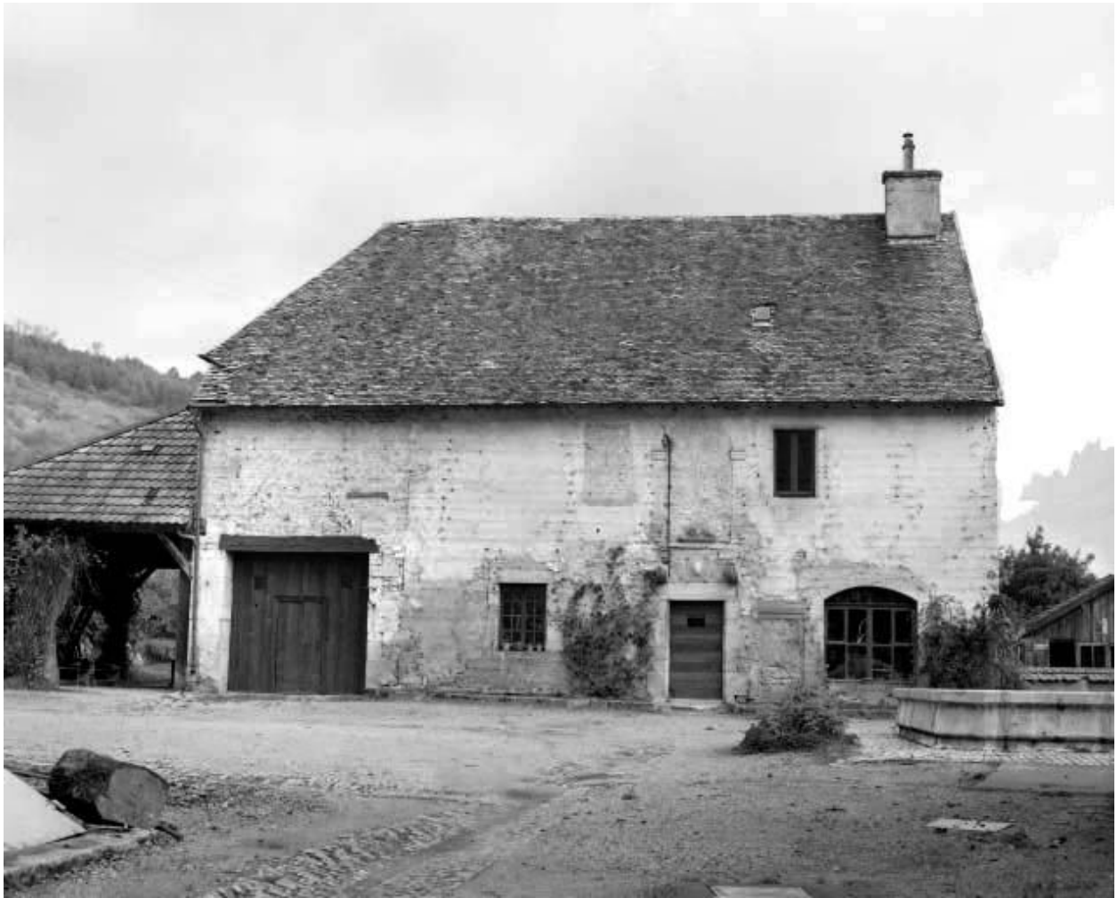
Façade antérieure de l'ancienne hôtellerie.
