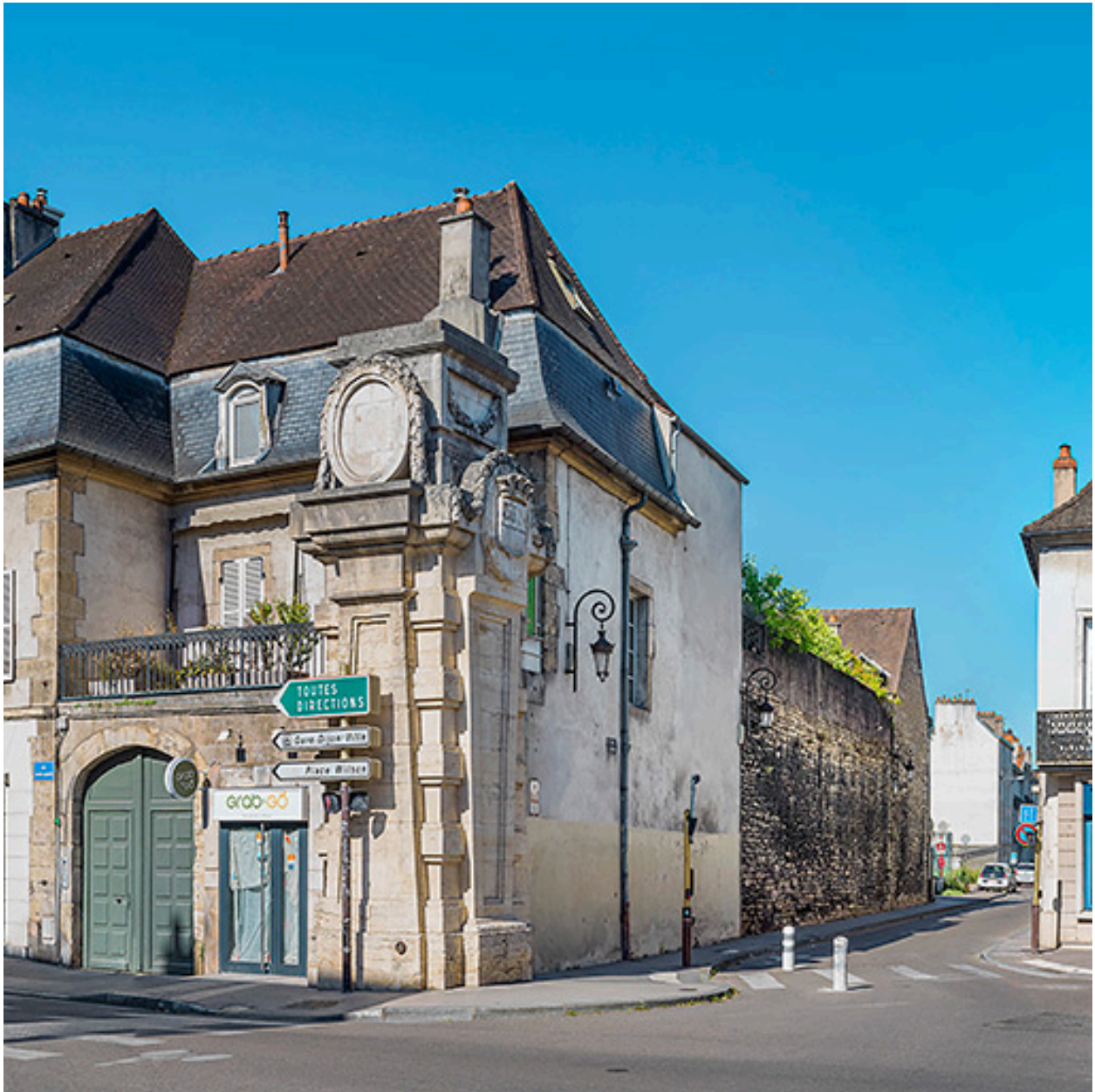
Pilastre de l'ancienne porte de ville Saint-Pierre, rue Chabot-Charny.
