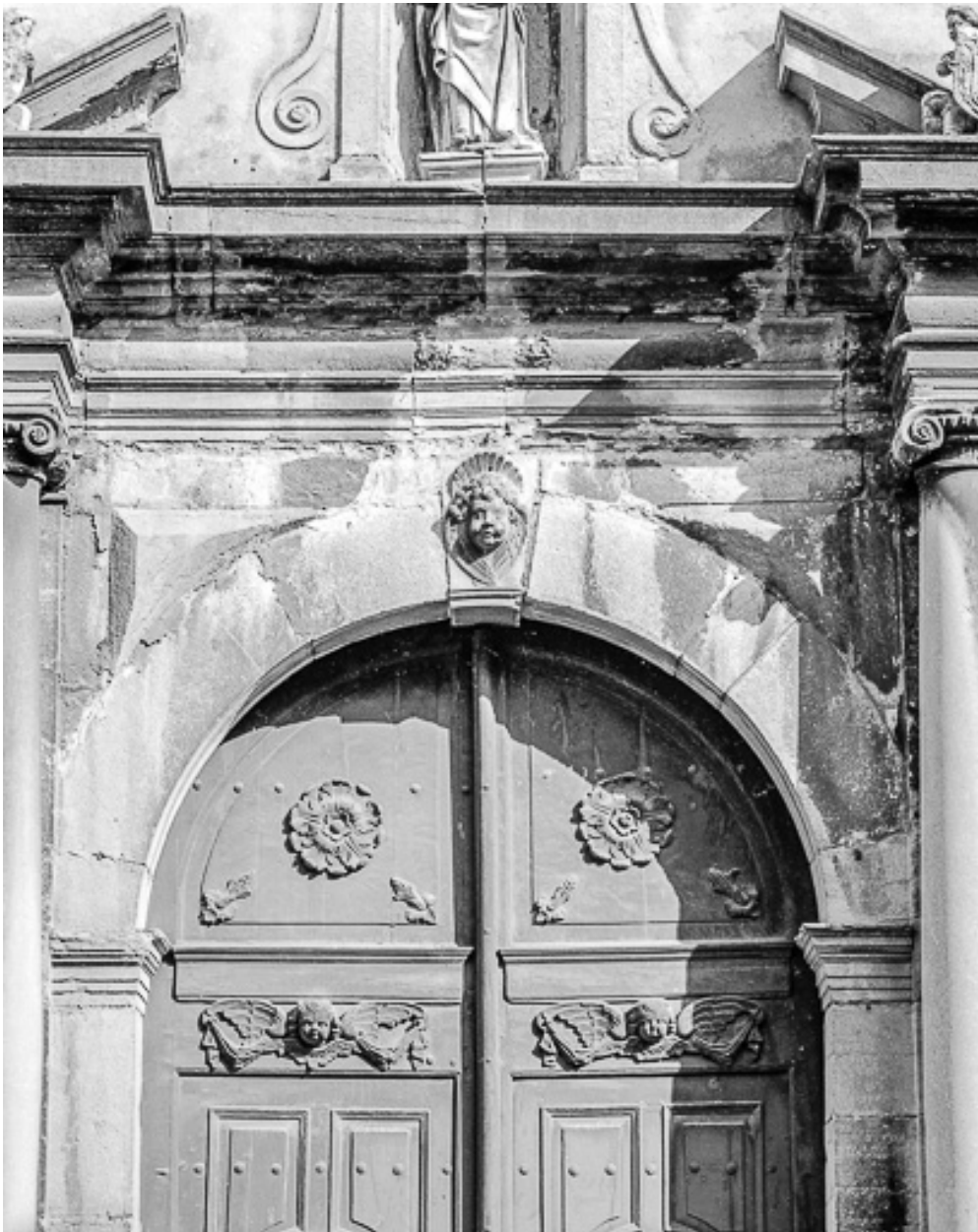
Portail de la façade antérieure : : partie supérieure.
