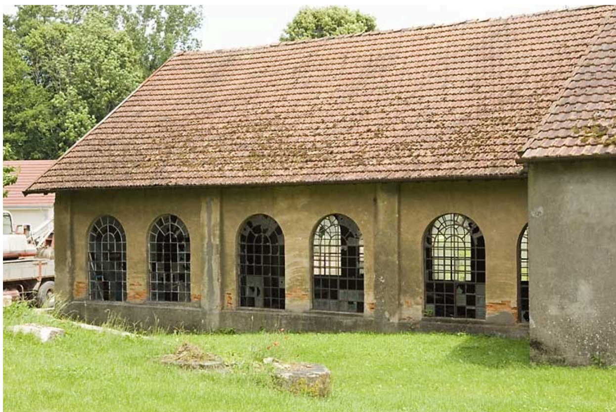
Façade ouest de l'atelier de fonderie.
