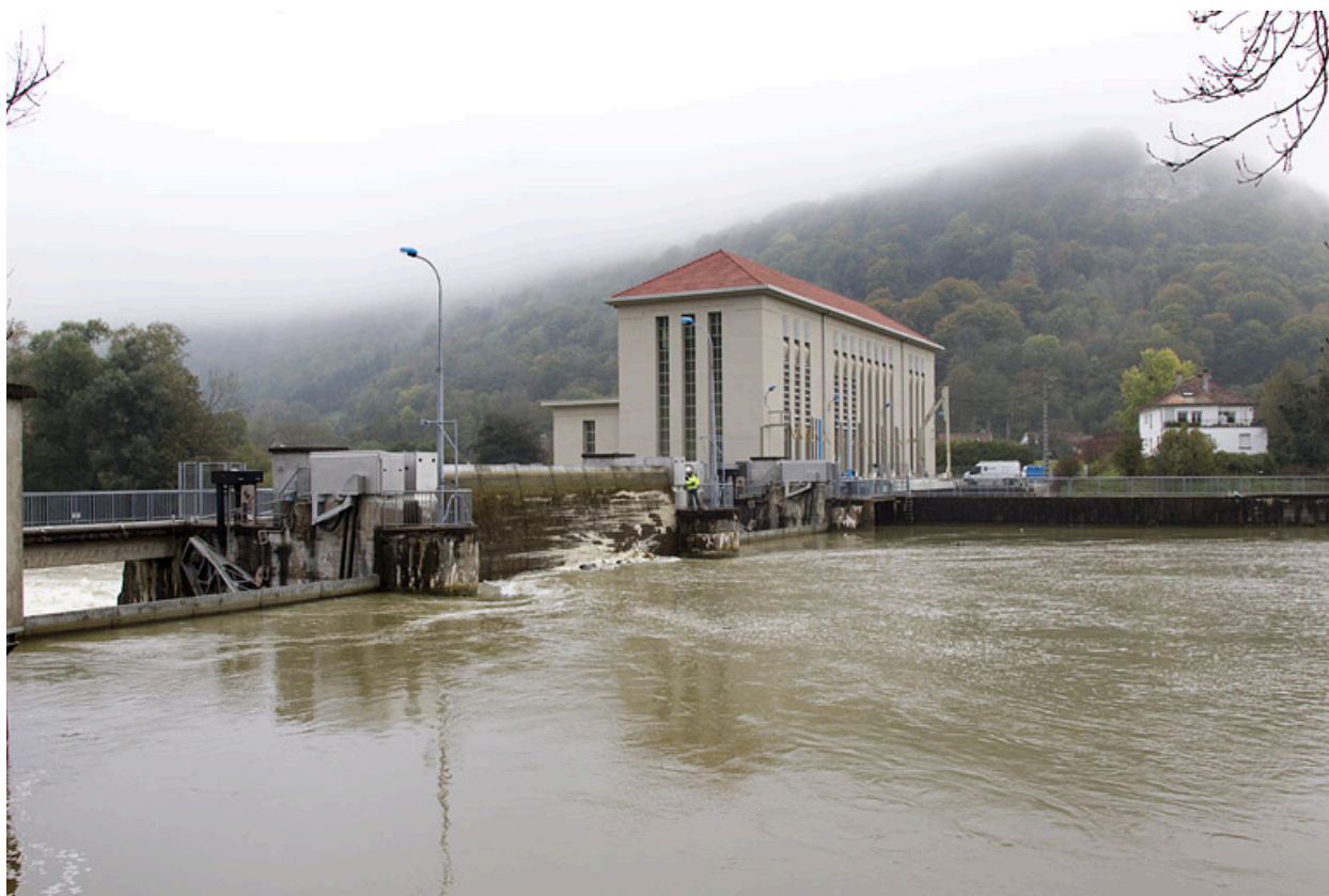
Le barrage et la centrale depuis l'ouest.
