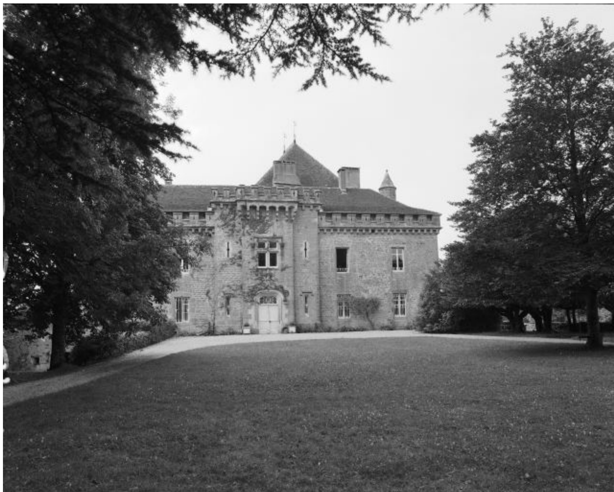
Le corps de bâtiment de façade.
