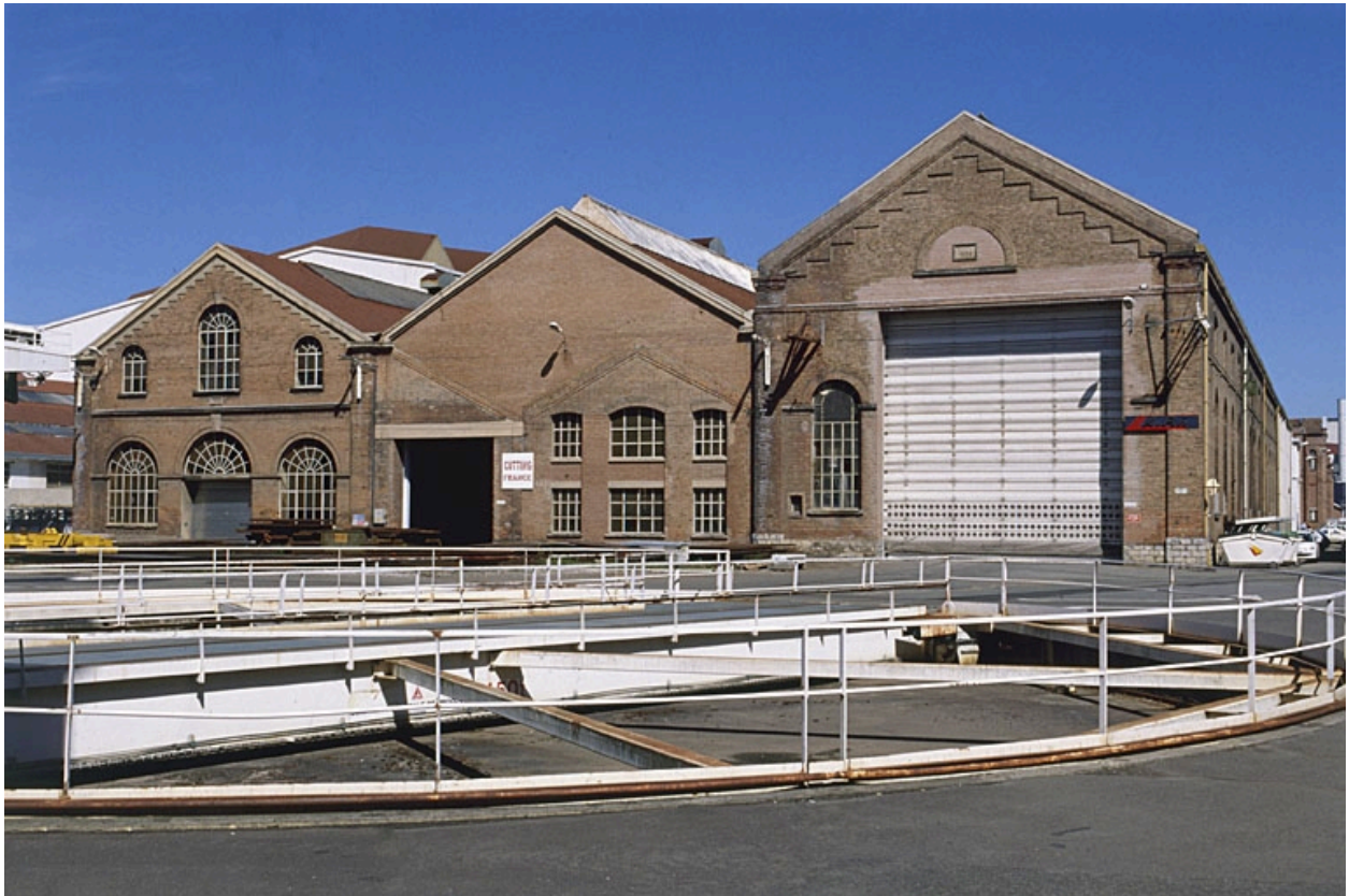
Vue de face des pignons des ateliers de métallurgie.
