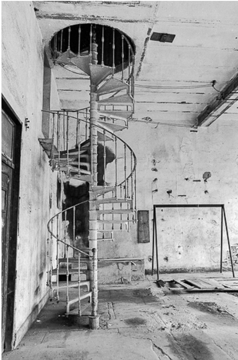
Vue intérieure en 1979. Escalier métallique.
