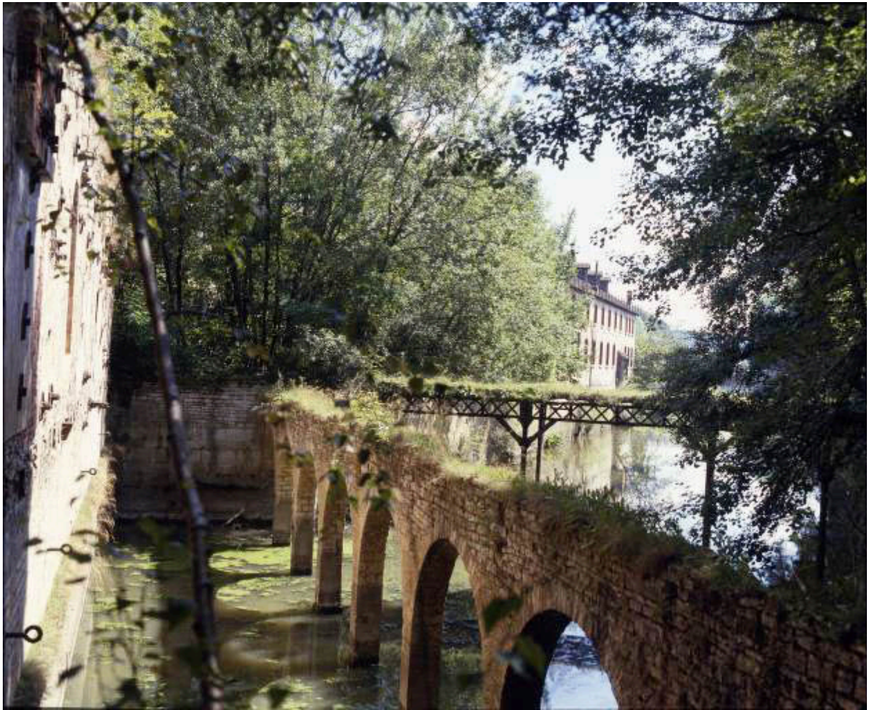
Vue depuis le canal de fuite en 1986 (cliché inversé).
