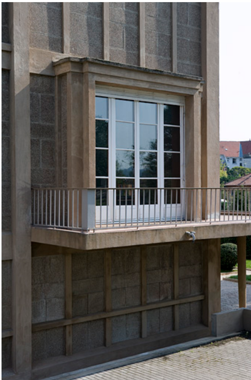
Façade postérieure : porte-fenêtre.
