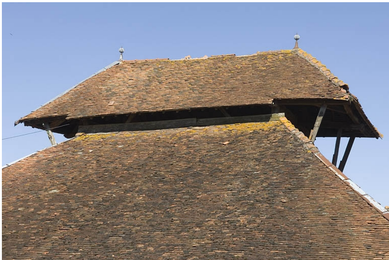
Lanternon du bâtiment du four.
