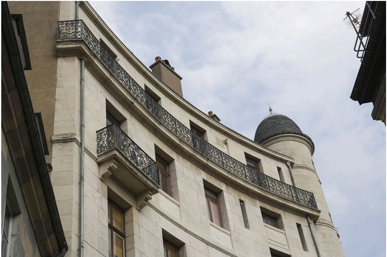
Détail du balcon filant sur la façade donnant rue Lacoré.
