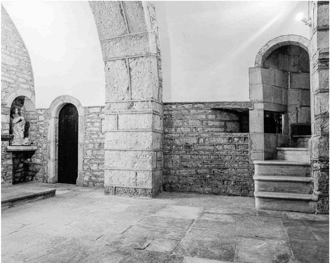
Bas côté droit, deuxième travée, mur ouest.
