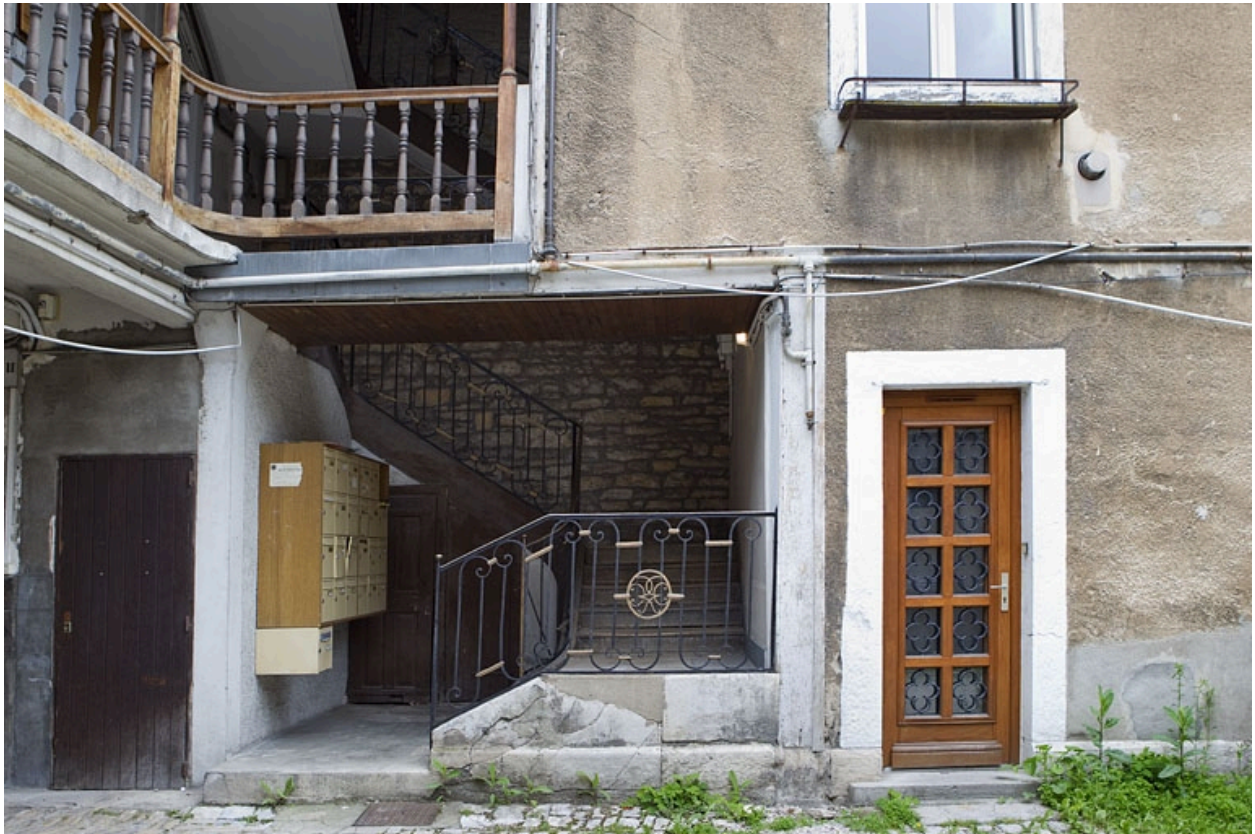
Détail du départ de l'escalier principal.
