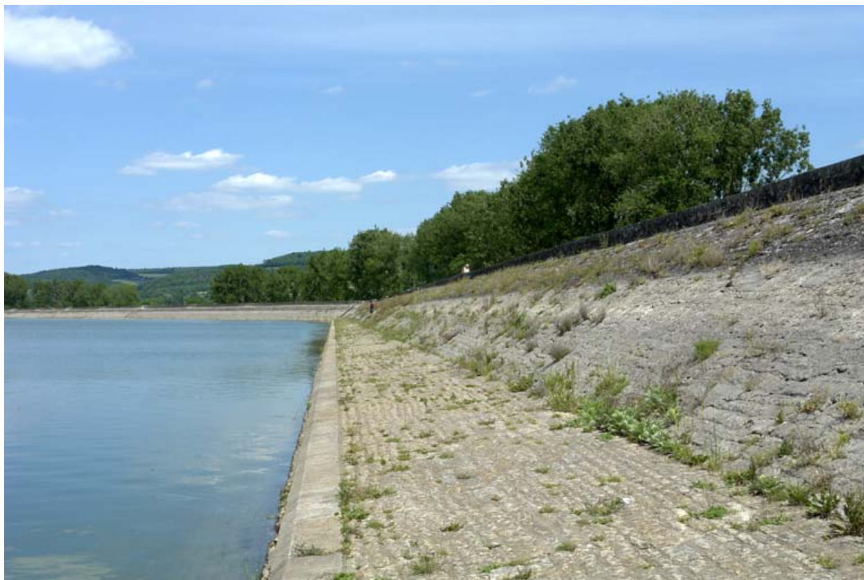
Digue est, vue d'ensemble.
