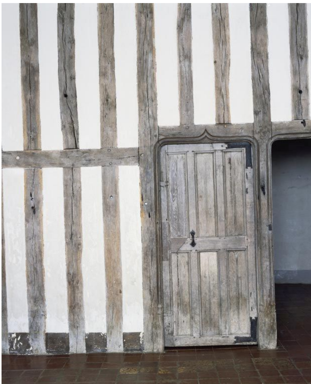
Logis principal, cloison en pan-de-bois dans une salle de l'étage.
