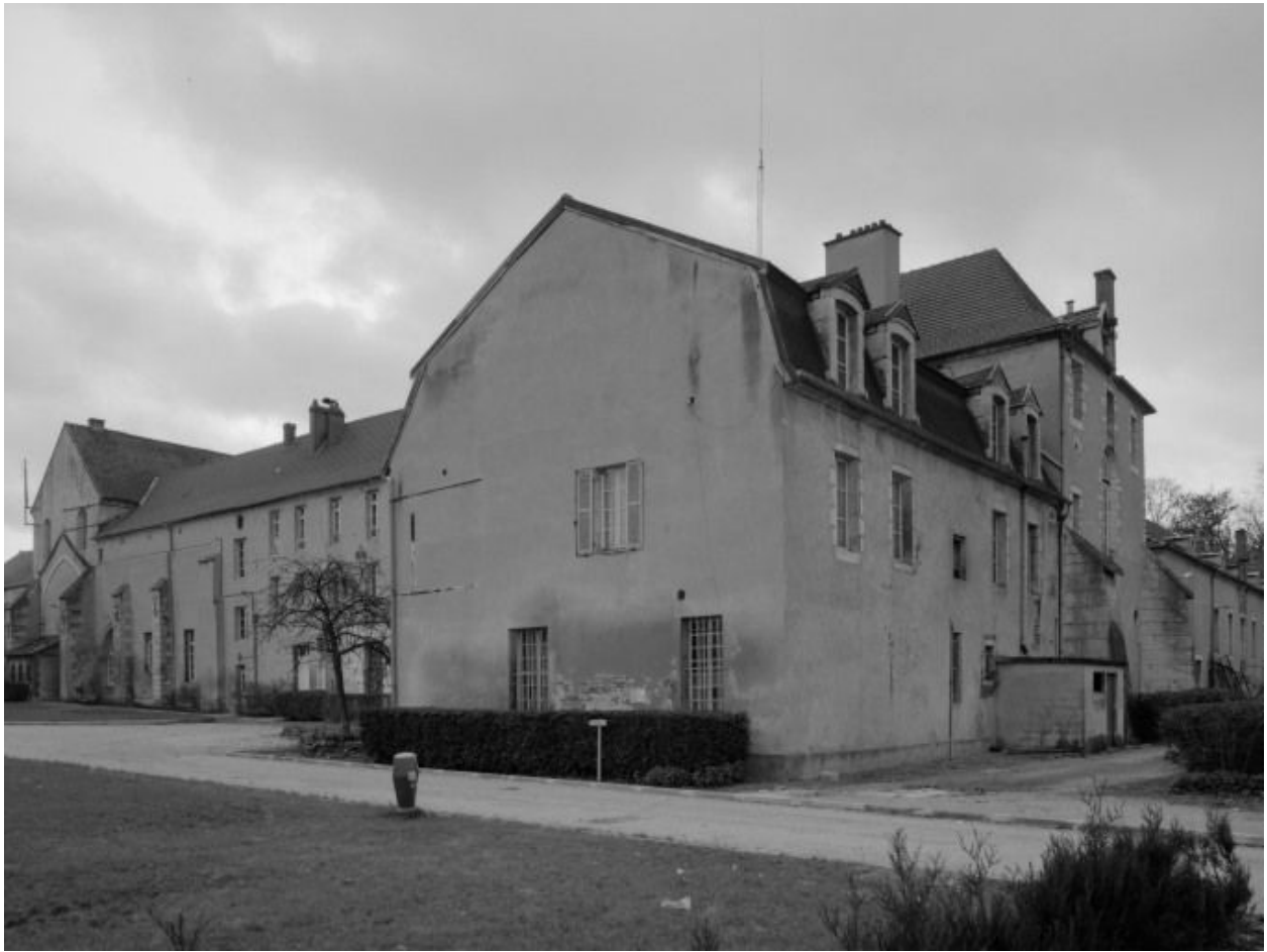
Bâtiment conventuel : élévations postérieure et latérale.
