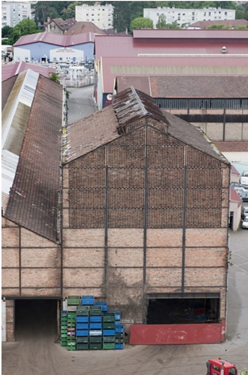
Vue plongeante sur le bâtiment du gazogène.
