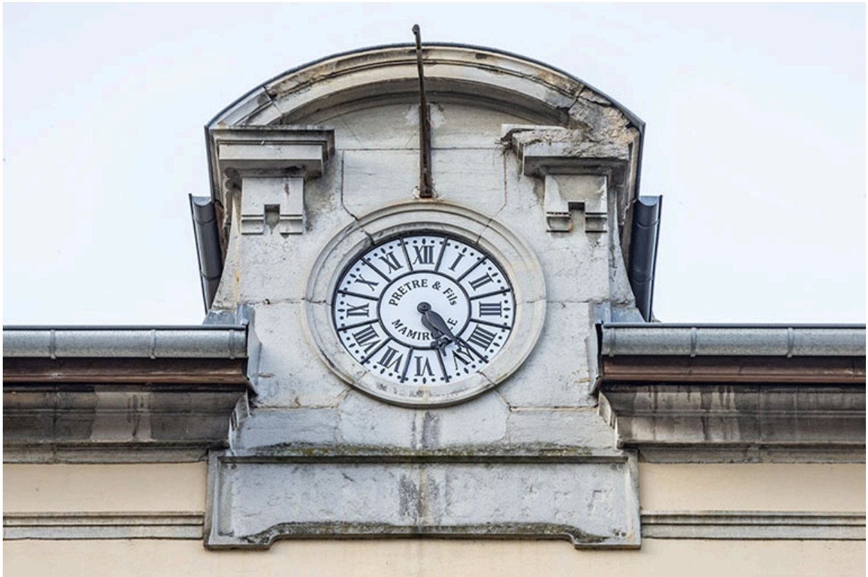
Horloge de la façade est.
