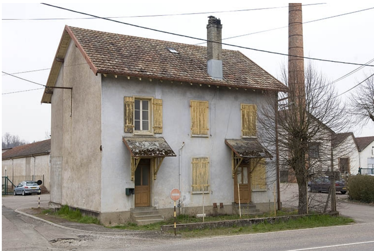
Logement à l'entrée de l'usine.
