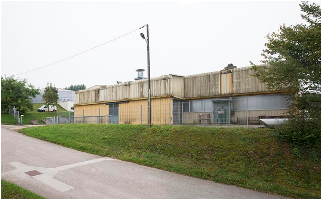
Atelier : façades Est.
