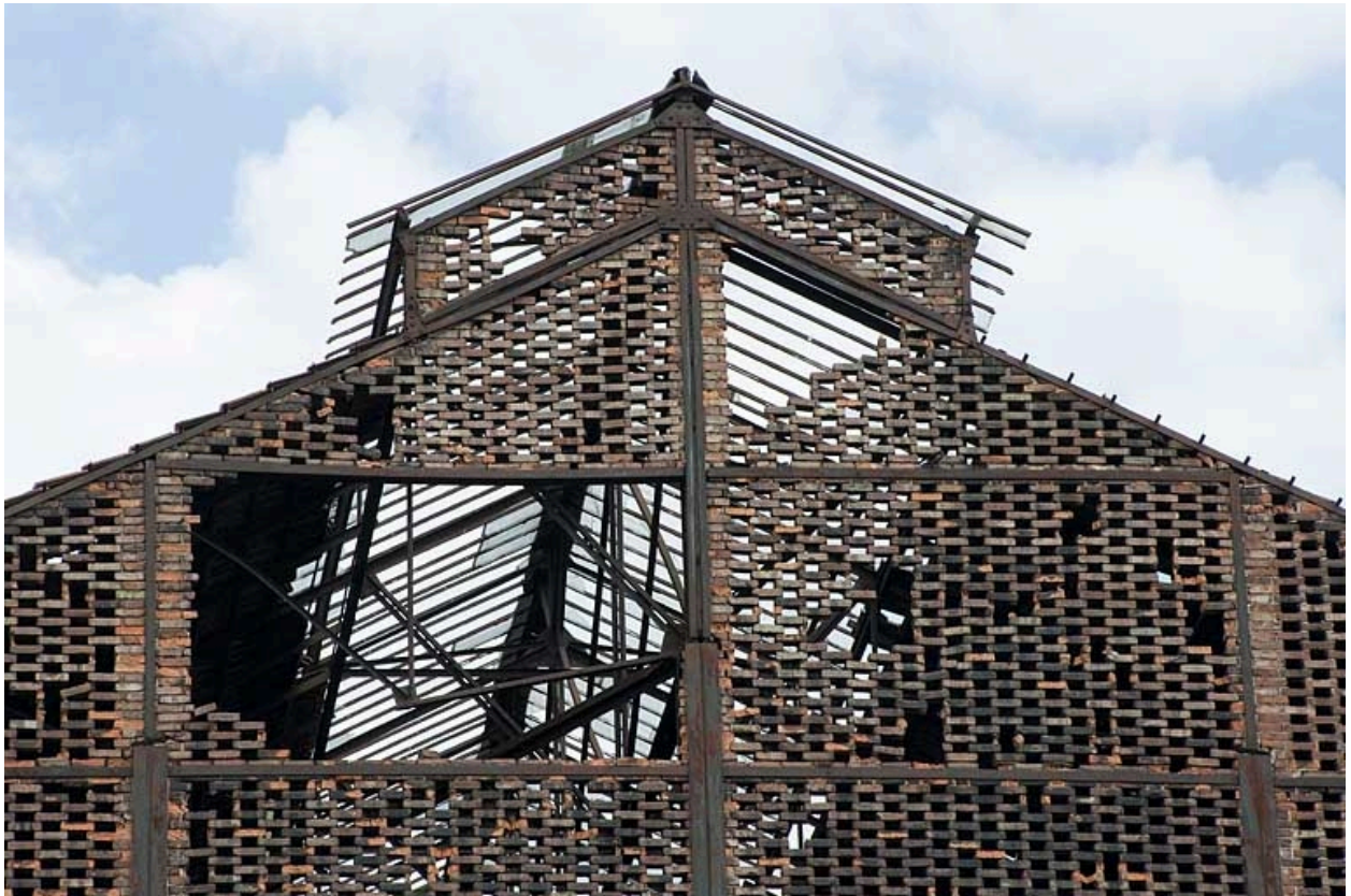
Bâtiment du gazogène. Pignon ouest.
