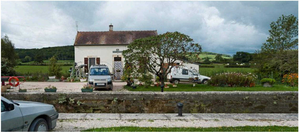
Vue de face de la maison éclusière.
